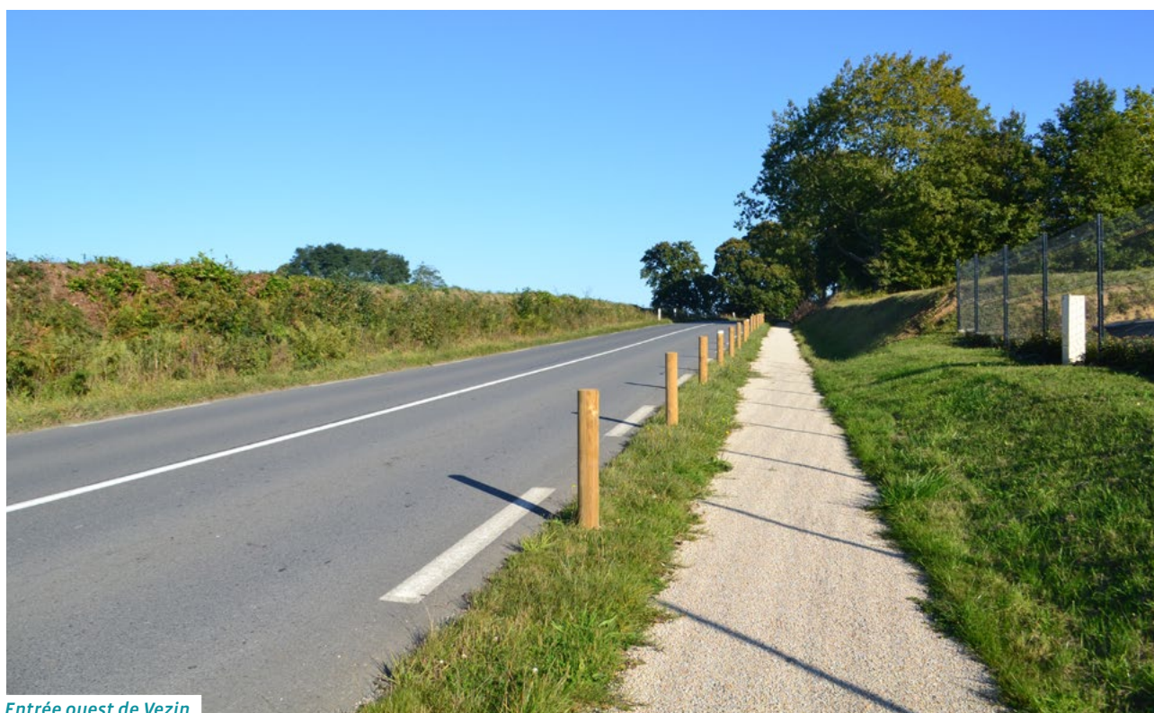
Entrée ouest de Vezin.
