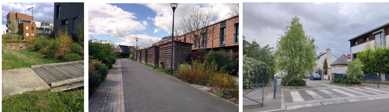
De gauche à droite : La Chapelle Thouarault (accès marqués par des passerelles), Vezin le Coquet (réduction de la largeur de voie ressentie par un large caniveau pavé) et rue Robiquet, Rennes (traitement végétal de l'entrée de rue)
