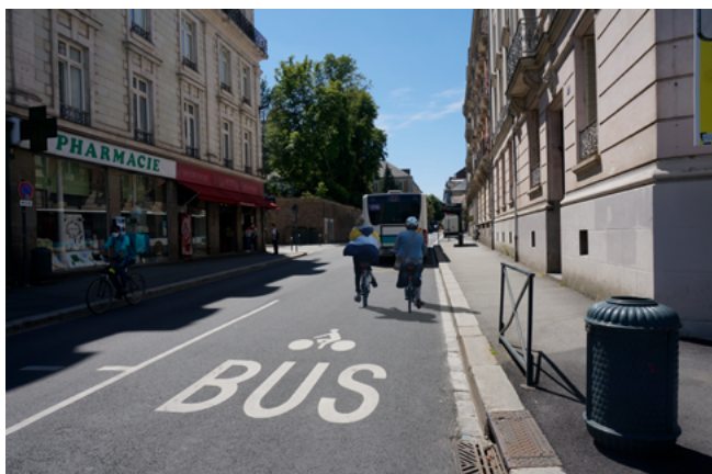
▲ Couloir mixte de largeur 3.50 m, Avenue Guillaudot
