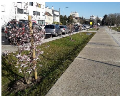
En haut de gauche à droite : Noue plantée offrant une double fonction : caractère de promenade plantée et gestion de l'eau, Bd de Vitré, Rennes.
