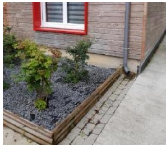
Déconnexion des eaux de gouttière du réseau – Rue Baderot à Rennes
