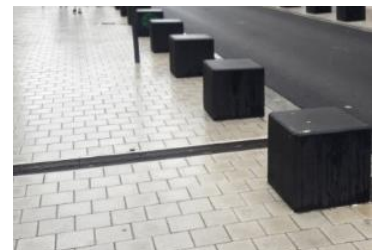
En haut à droite : Caniveau gargouille à ciel ouvert sur trottoir créant une trame urbaine, Rue Plélo (Rennes)
