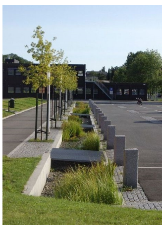
NOUE/GESTION DES EAUX PLUVIALES.
