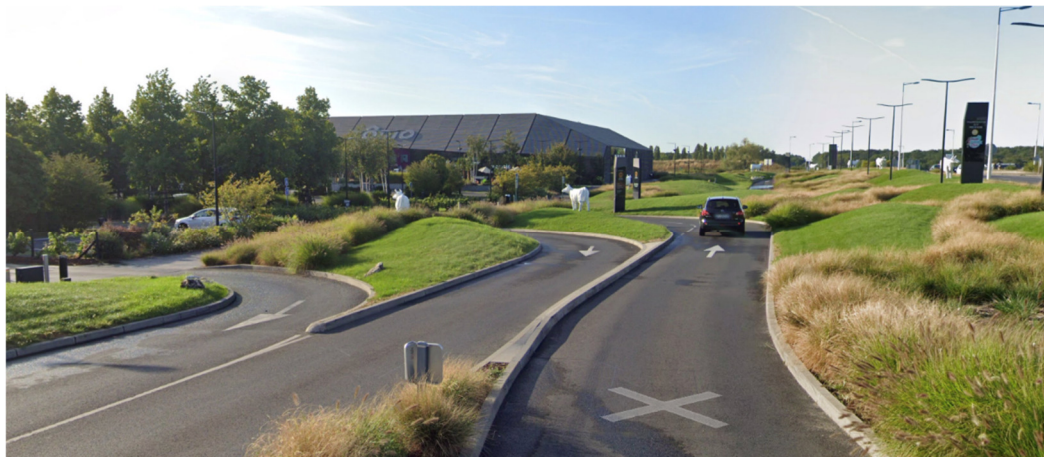
TRAITEMENT D'UNE ENTREE : MOUVEMENTS DE SOL ET PLANTATIONS BASSES ENTRE LA ZONE COMMERCIALE ET LA RD LA LONGEANT, PLANTATIONS ARBOREES SUR LES VOIRIES INTERNES, ECLAIRAGE CONTEMPORAIN.
