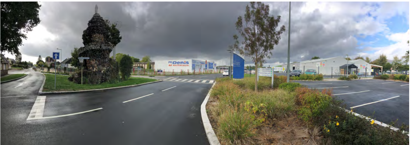
Situation du bâtiment
