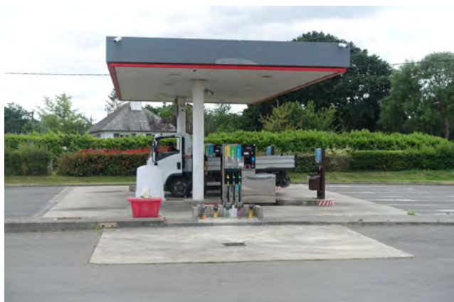
Station service sur le site ré-ouverte depuis 5 ans
