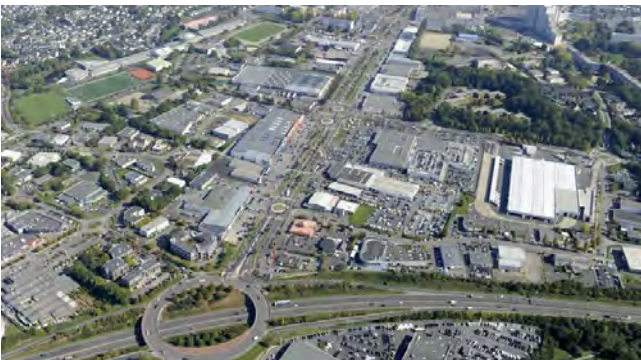
Vue aérienne du site commercial de la rue de Vannes à Nantes
