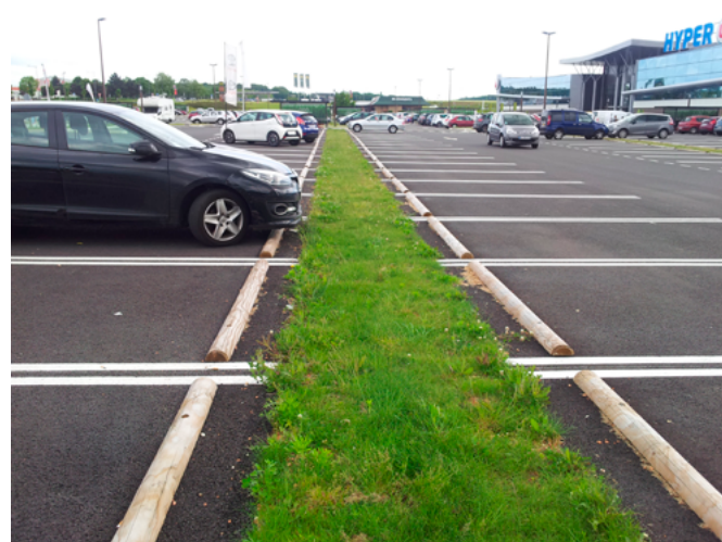
Noue drainante : une solution quand on ne peut pas végétaliser les places de parking. Crédit : © Écovégétal.
