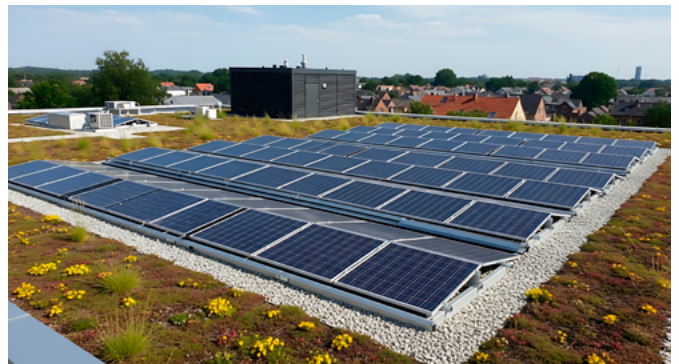
Toiture mixte combinant solarisation, végétalisation et gestion des eaux pluviales.
