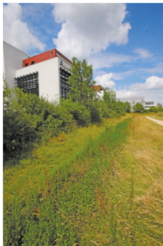
Noue d'infiltration dans le quartier des Longchamps, à Rennes. Crédit : © Didier Gouray / Rennes, Ville et Métropole.
