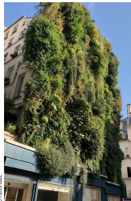
Mur végétal, rue d'Aboukir, Paris (2 ème arr.).
