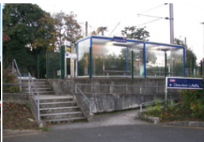
Accès au quai par l'escalier ou par une rampe en gare de Cesson-Sévigné
