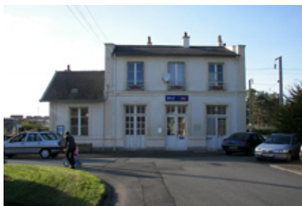
Manque de cheminements piéton devant le bâtiment voyageurs
