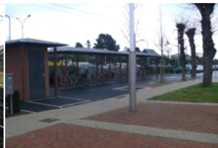
Parking vélo abrité attenant au bâtiment voyageurs de la gare de Betton
